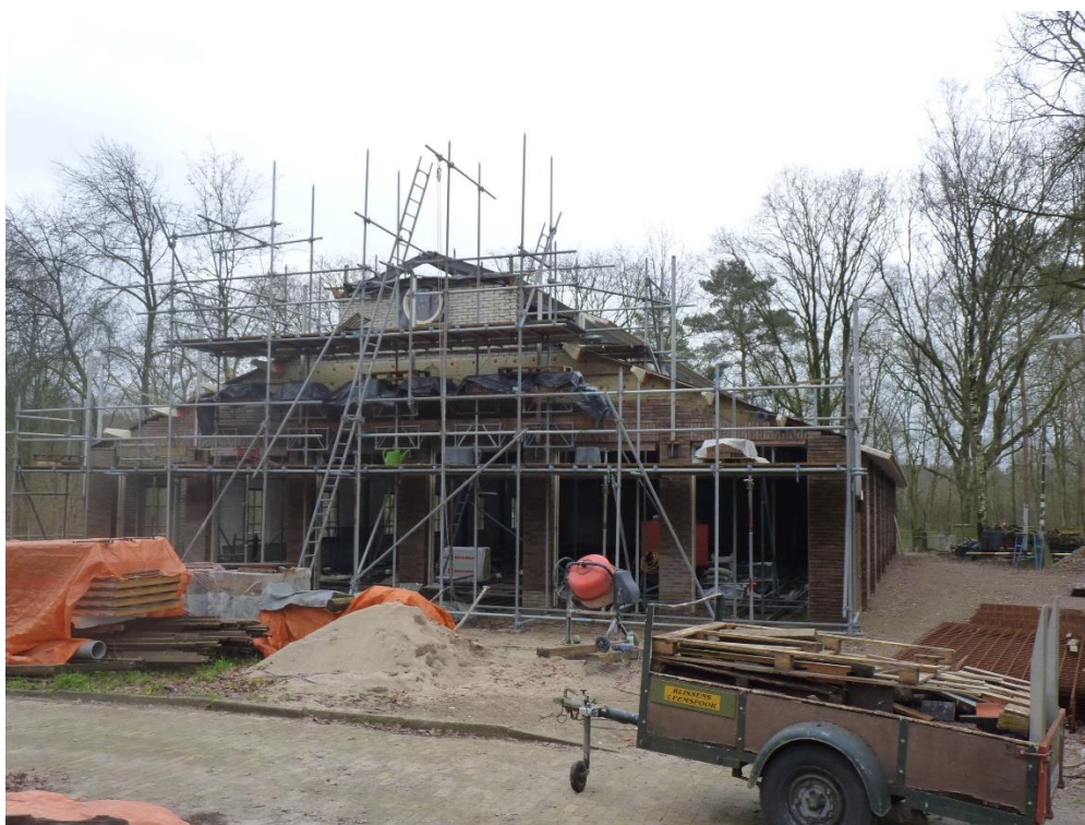
Nieuwe loods - in aanbouw, kerst 2023
